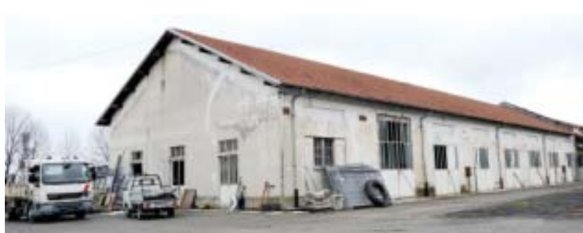
Il capannone dell'ex caserma Filippi dove sorgerà il dormitorio
