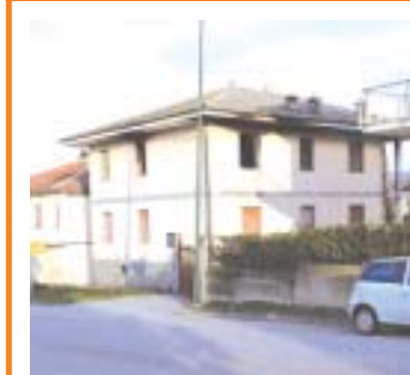
La palazzina teatro dell'incendio
